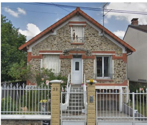
Maisons meulières, TREMBLAY-EN-FRANCE
