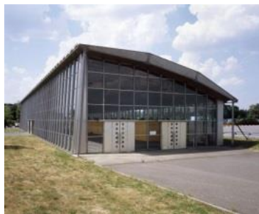
Pavillon de l'Aluminium démontable
