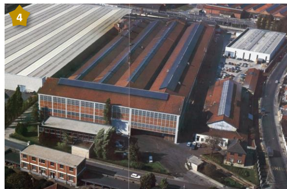
Tubes de Montreuil (grande halle et bureaux), LE BLANC-MESNIL
