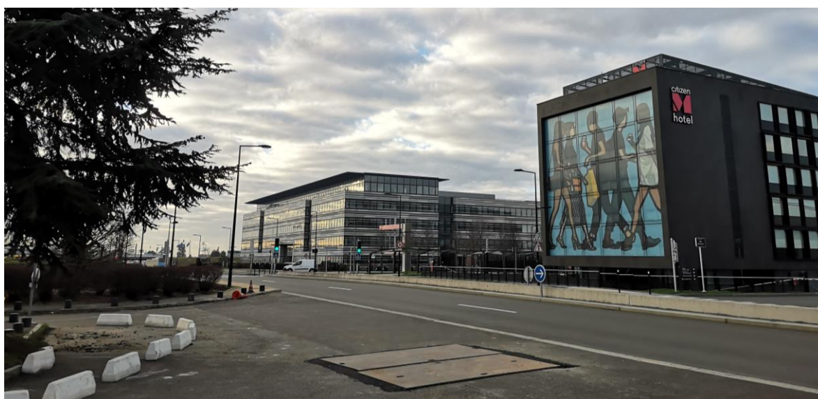
Source : Espace Ville (aéroport CDG ; Tremblay-en-France)
