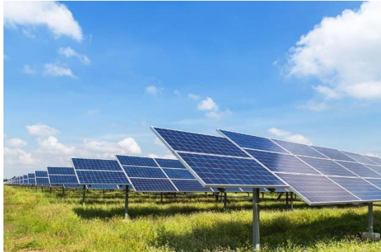
Panneaux photovoltaïques en zone agricole
