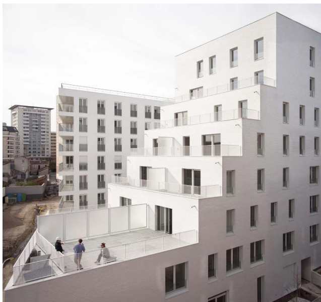
Exemple d'immeubles à hauteur progressive
