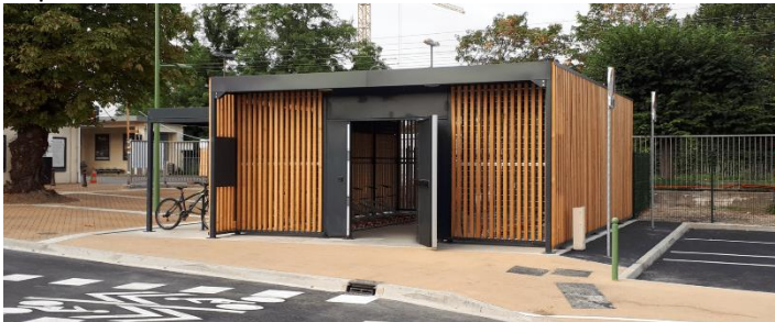
Abri vélo sécurisé avec éclairage naturel
